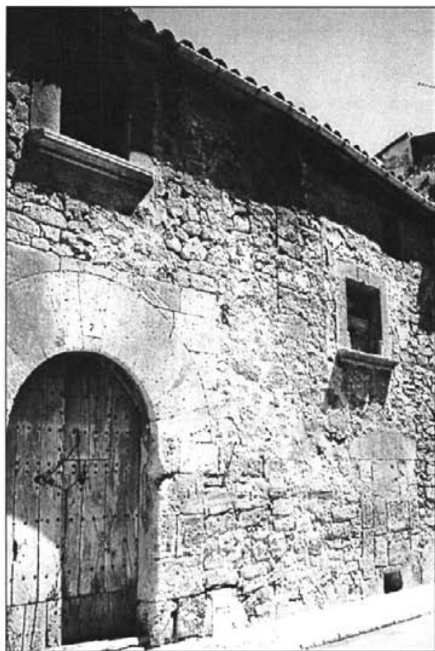
Casa petita de Ca'n Clar. Futura biblioteca?
