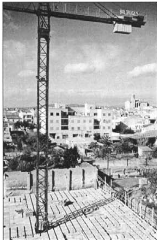
Les obres al solar de la Serradora de Can Meco
