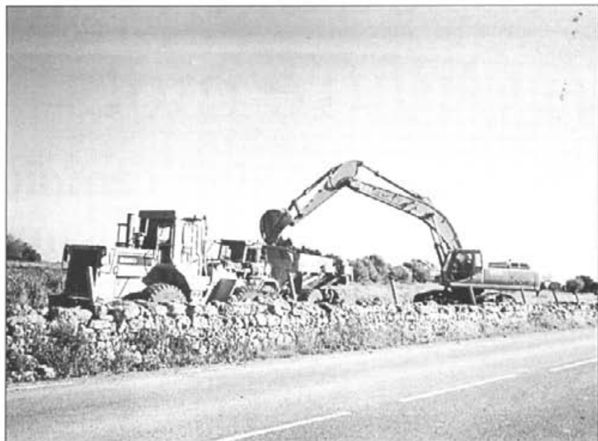
Els caramulls de terra indiquen l'inici de les obres
