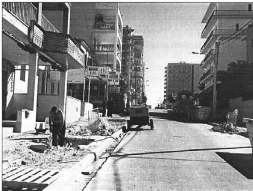
Les obres del Carrer Sant Bartomeu finalitzaran el mes de març
