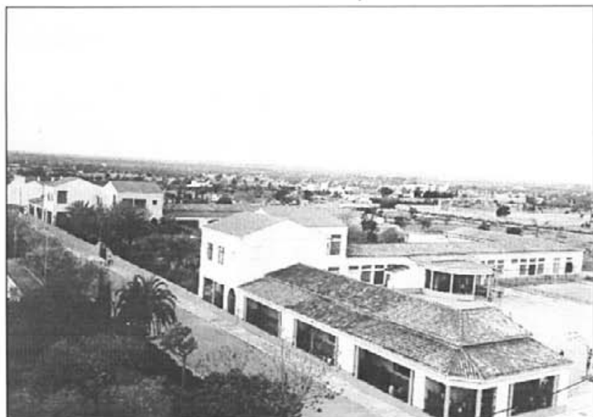
L'actual edifici, dissenyat per l'arquitecte Guillem Forteza.
