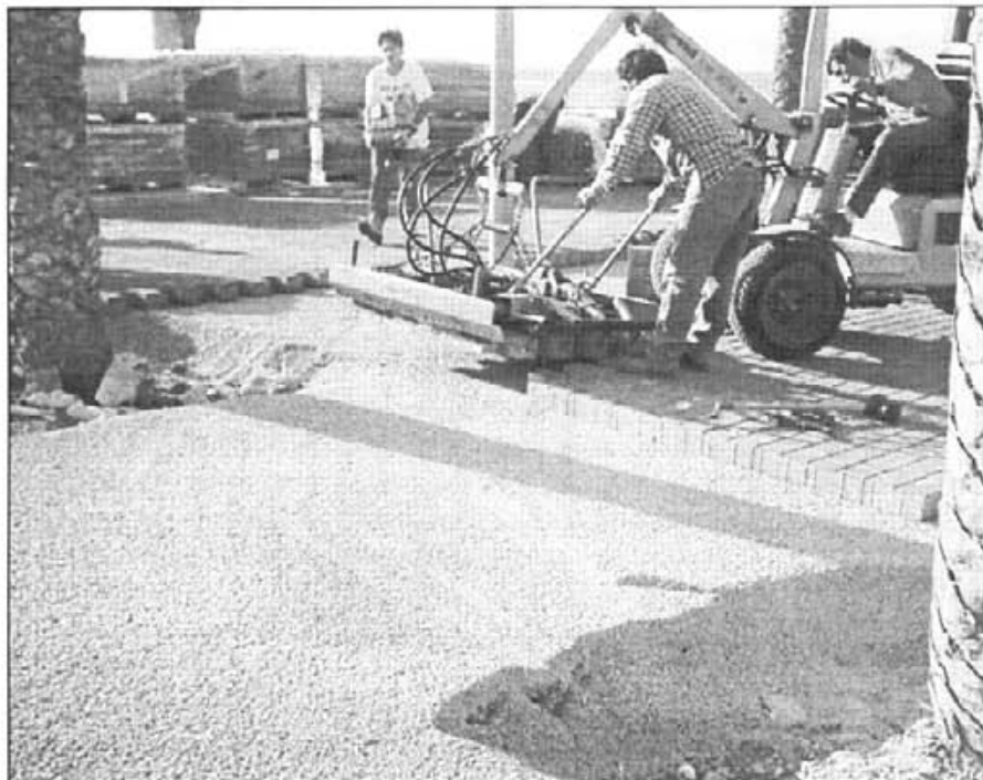
Les obres de primera línia arribaren al final (Foto: Joan Vich)
