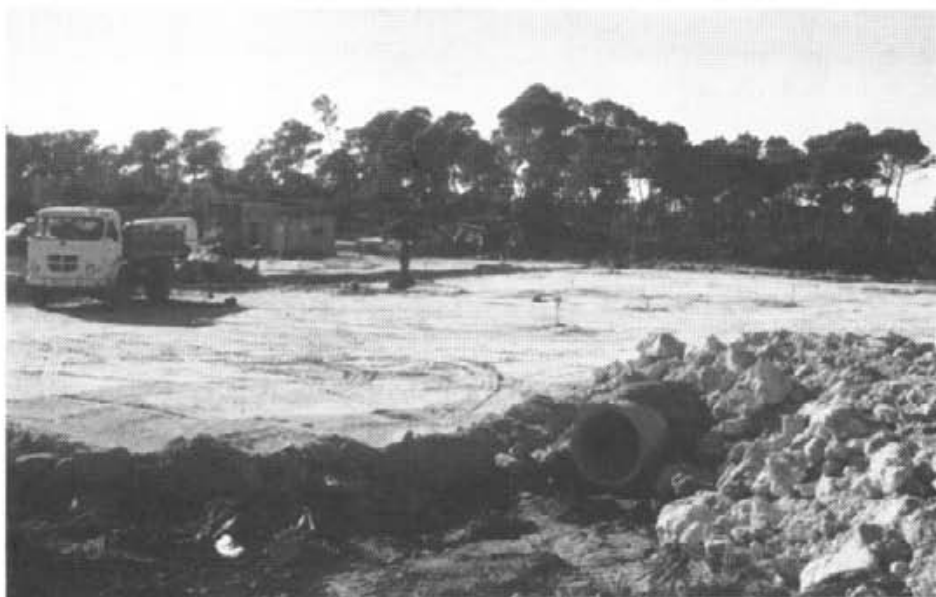
Han començat les obres per a la nova benziner a Son Verí, Carretera Lluçmajor- S'Arenal (Fotos: C. Julià).
