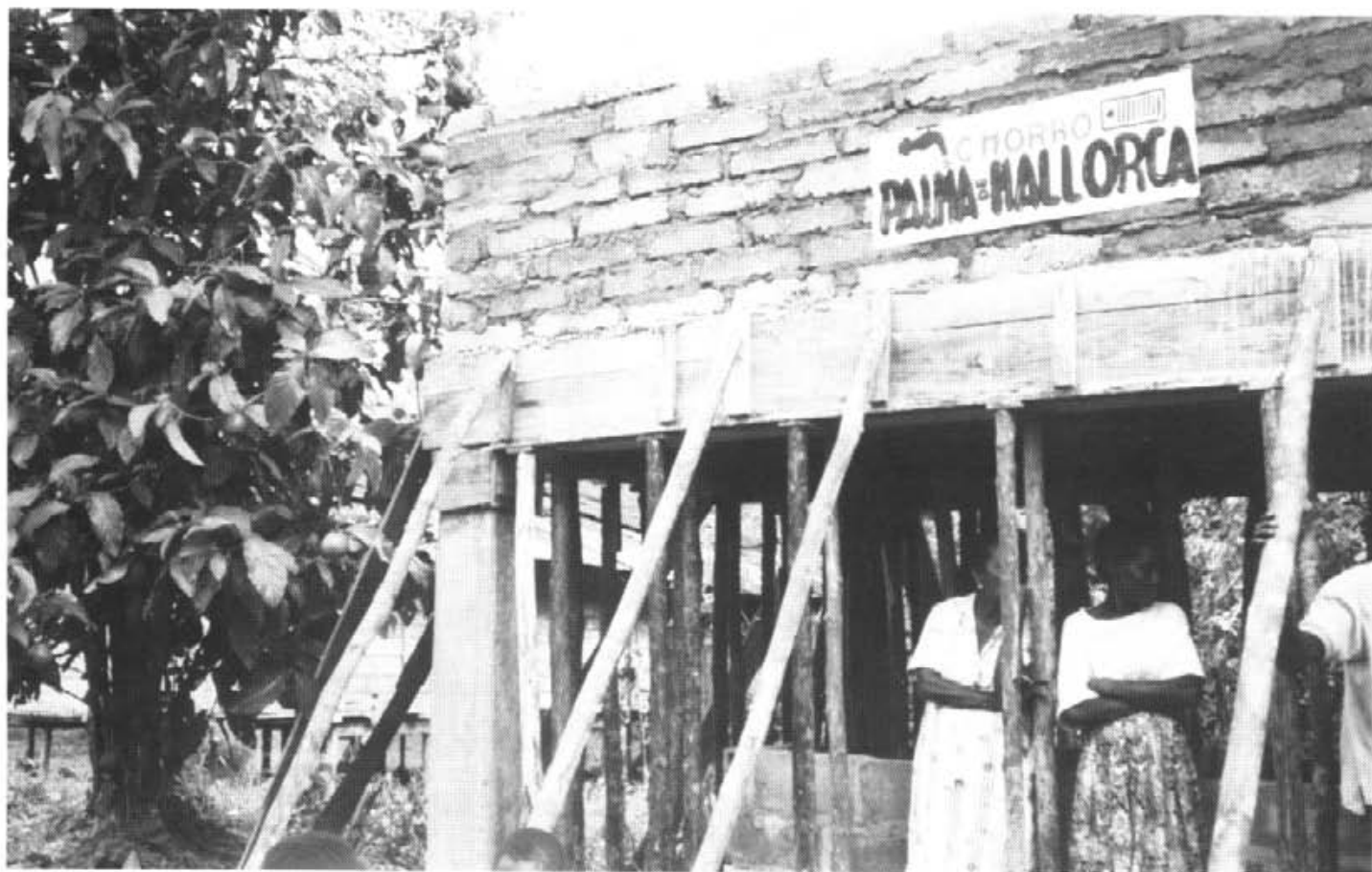
Construcció d'un dels dipòsits recol.lectors d'aigua de pluja
