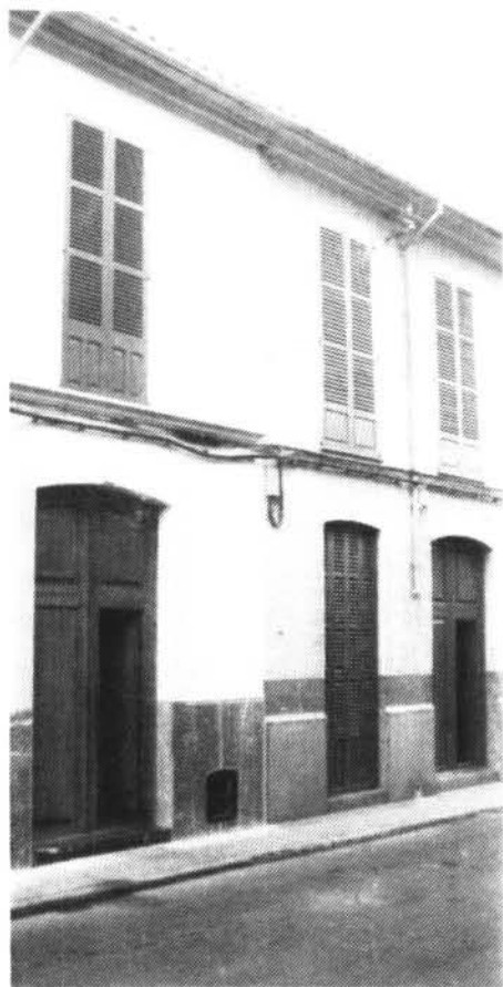
Cases del C. Sindicat n. 12 i 14, construïdes pels dos germans Antoni i Miquel Company.
