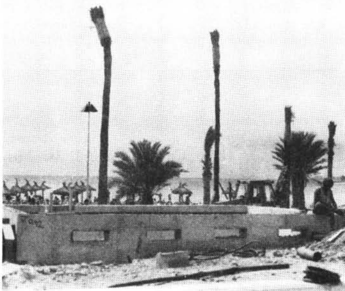
Nova edificació per a un Grup Electrògen
