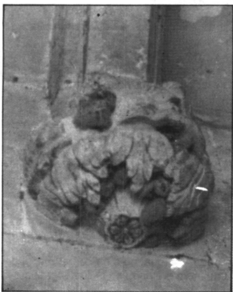
Detall d'un capitell de la noble construcció de Sa Torre
