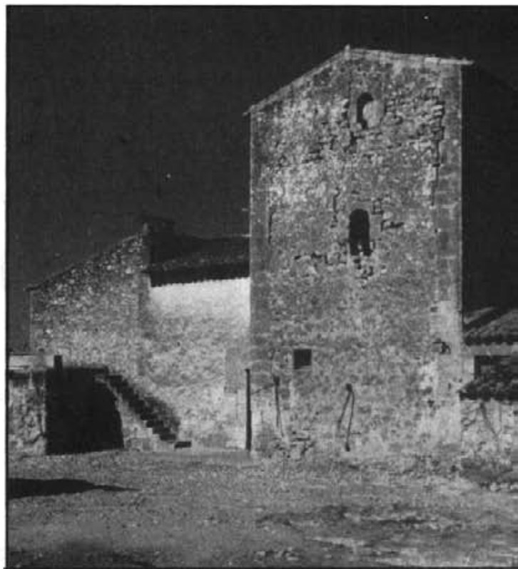
Les cases tenen una torre de defensa conservada
