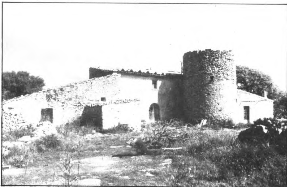
Una torre de defensa de planta circular en un cantó de les cases de S'Allapasseta.
