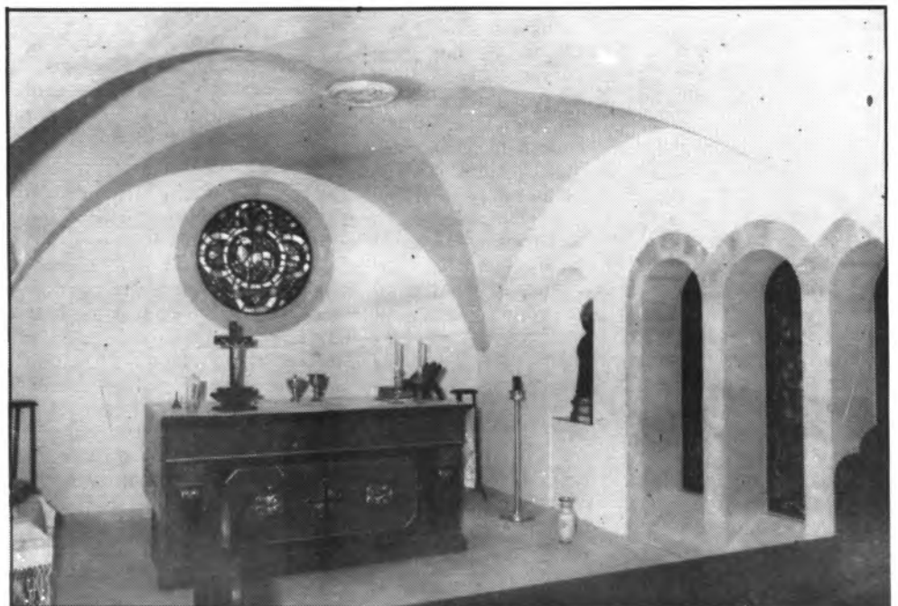
Un aspecte de la capella, també restaurada.
