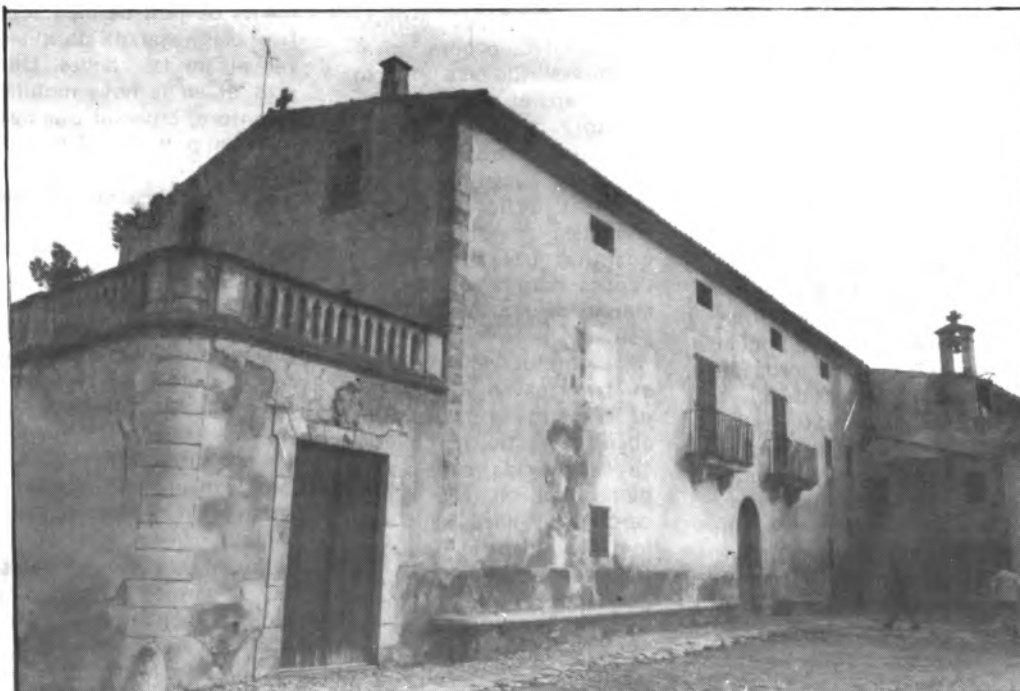
Façana principal de les cases de Païssa
