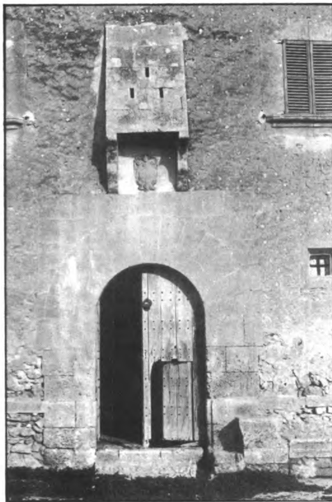
L'entrada principal amb el matacà per a la defensa.
