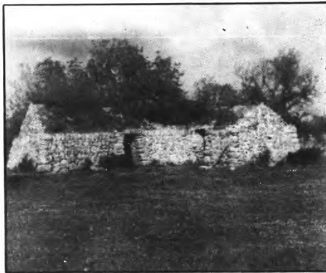
Les barraques es construïen afegides per aprofitar la paret amitgera.
