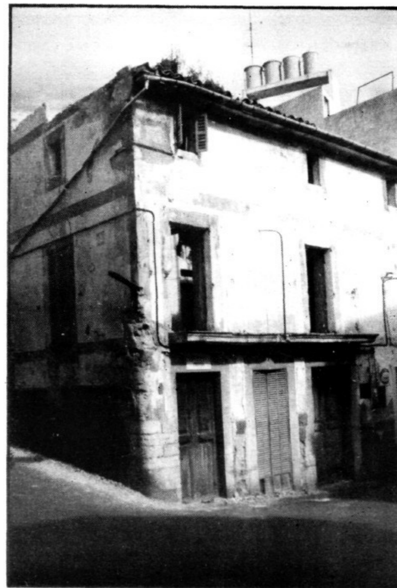
El edificio poco antes de ser derruido.
