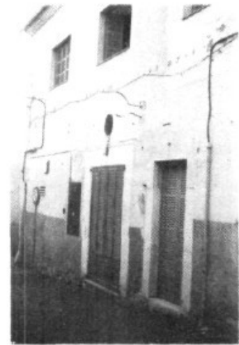
Cerrada esta información nos llega la noticia concreta de que hasta el mes de Mayo de 1985 no entrará la nueva central en funcionamiento y será cuando serán instalados los nuevos teléfonos.
