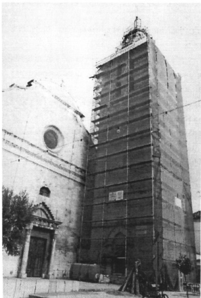
3. Campanar de Santa Maria la Major amb les bastides de l'obra.
