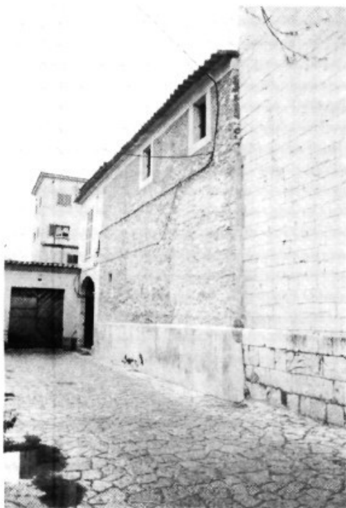
Façana del Claustre dels Dominics
