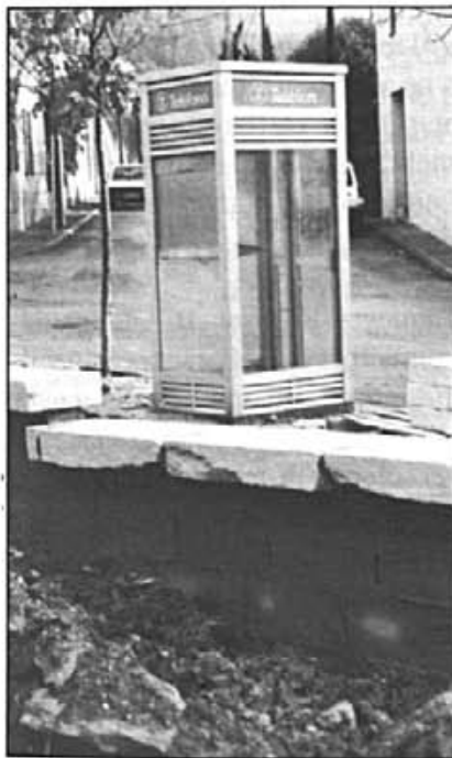
Un detall de les obres: Peces rompudes pagades a preu de noves
