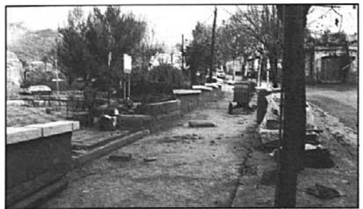
La Plaça de l'Ajuntament en obres
