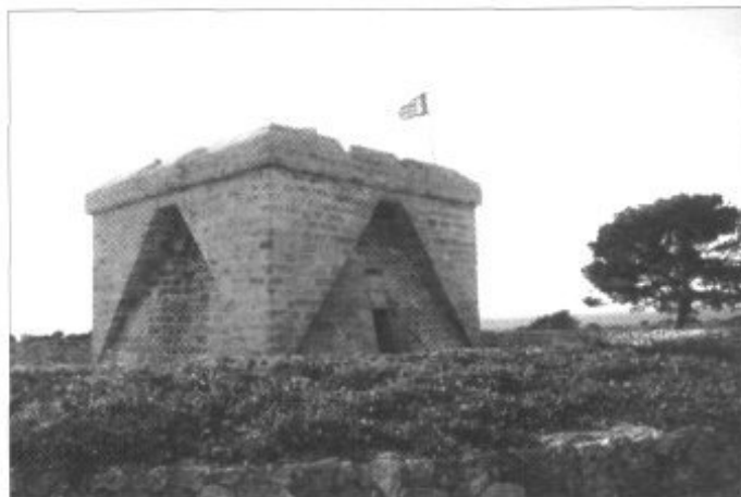
Aspecte que ofereix l'exterior de l'edifici
