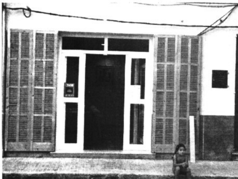
Locutori telefònic del carrer Costa i Llobera
