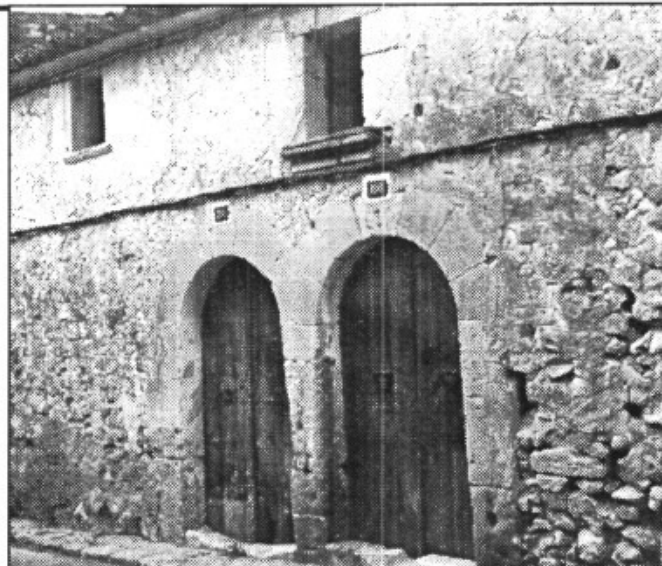
Cases amb portal rodó del carrer de s'Arraval
