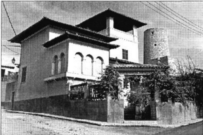
Cas Manescal. Ses Corbates. Arquitecte Francesc Cerdó Rossiñol. 1949.
