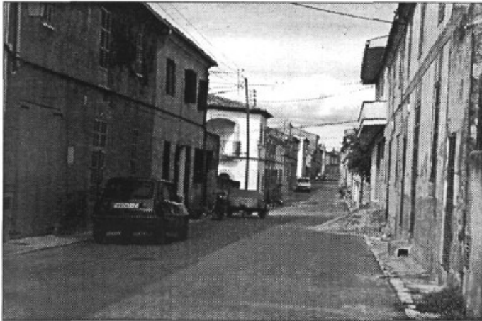
Reformes al carrer Major.
