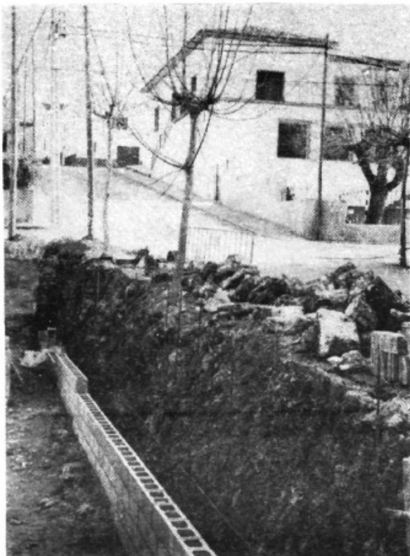
L'ASFALTAT D'ALGUNS CARRERS OBLIGA A FER MURS DE CONTENCIÓ
