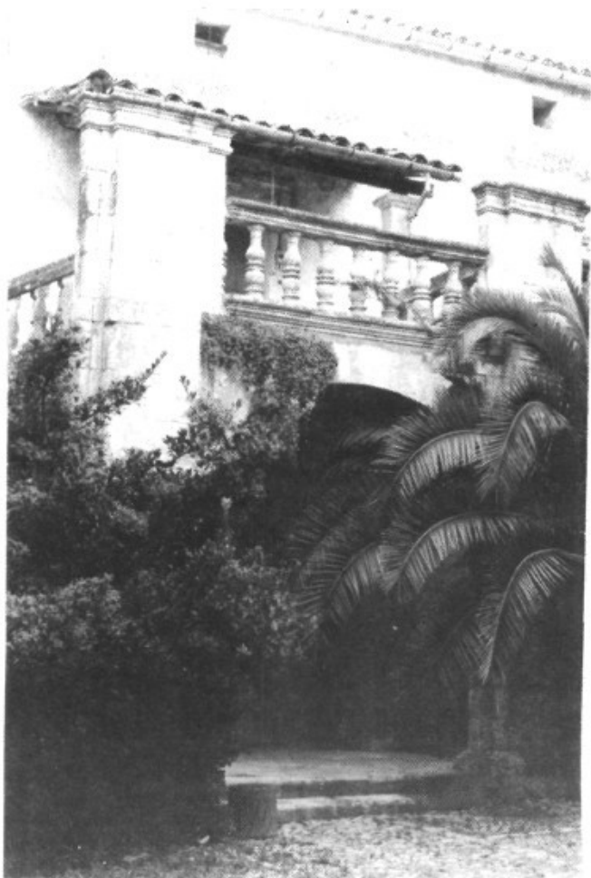
Detall de l'escala que dona a la cisterna
