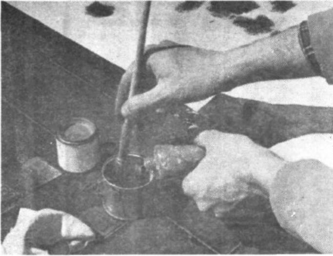
metálicos del calentador de gas o las tuberías del cuarto de baño, conviene lijarlos y darles una mano de minio y dos de pintura del color
