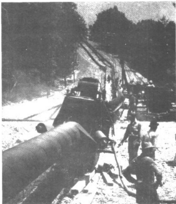
Los oleoductos conducen gas y combustibles líquidos a través del país hasta hogares y fábricas. Este transportará gas natural de Tejas a West Virginia.
