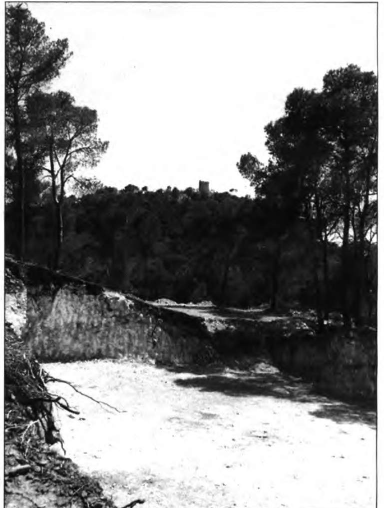
Na Clàudia Schiffer ha comprat tota sa punta del Cap Andritxol, la torre de defensa inclosa. Vet aquí la excavació per a construir el seu segon xalet. Foto Mitchel.
