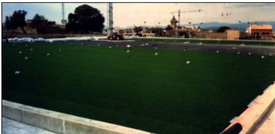
Setembre de 2002. Moment de la instal·lació de la catifa de gespa artificial al camp des Porrassar.
