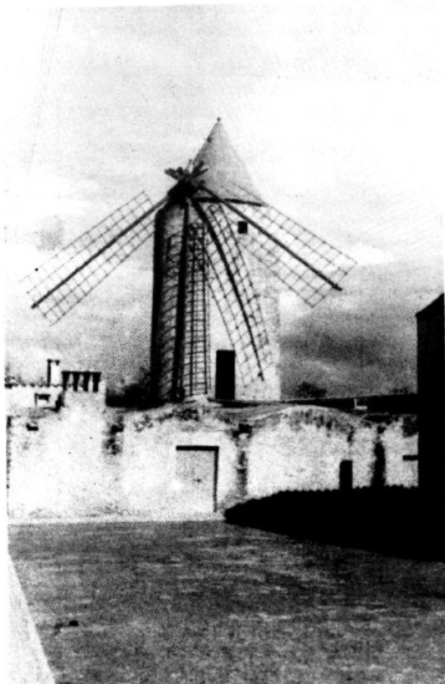
Aquestes dues fotografies de l'any 1947 mostren el procés de col·locació del ramell nou
