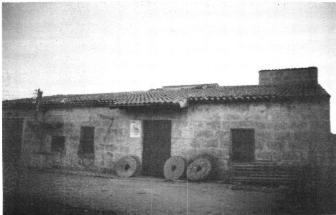
Sa Farinera, el nou local de la Cooperativa
