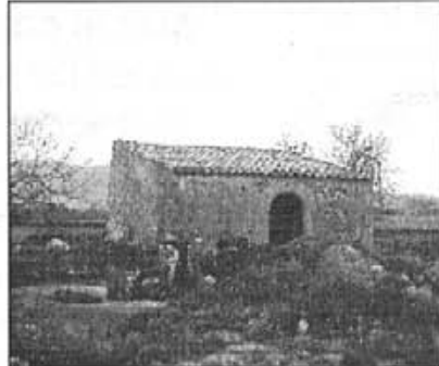
Procés de construcció de la teulada de Son Pere Jaume
