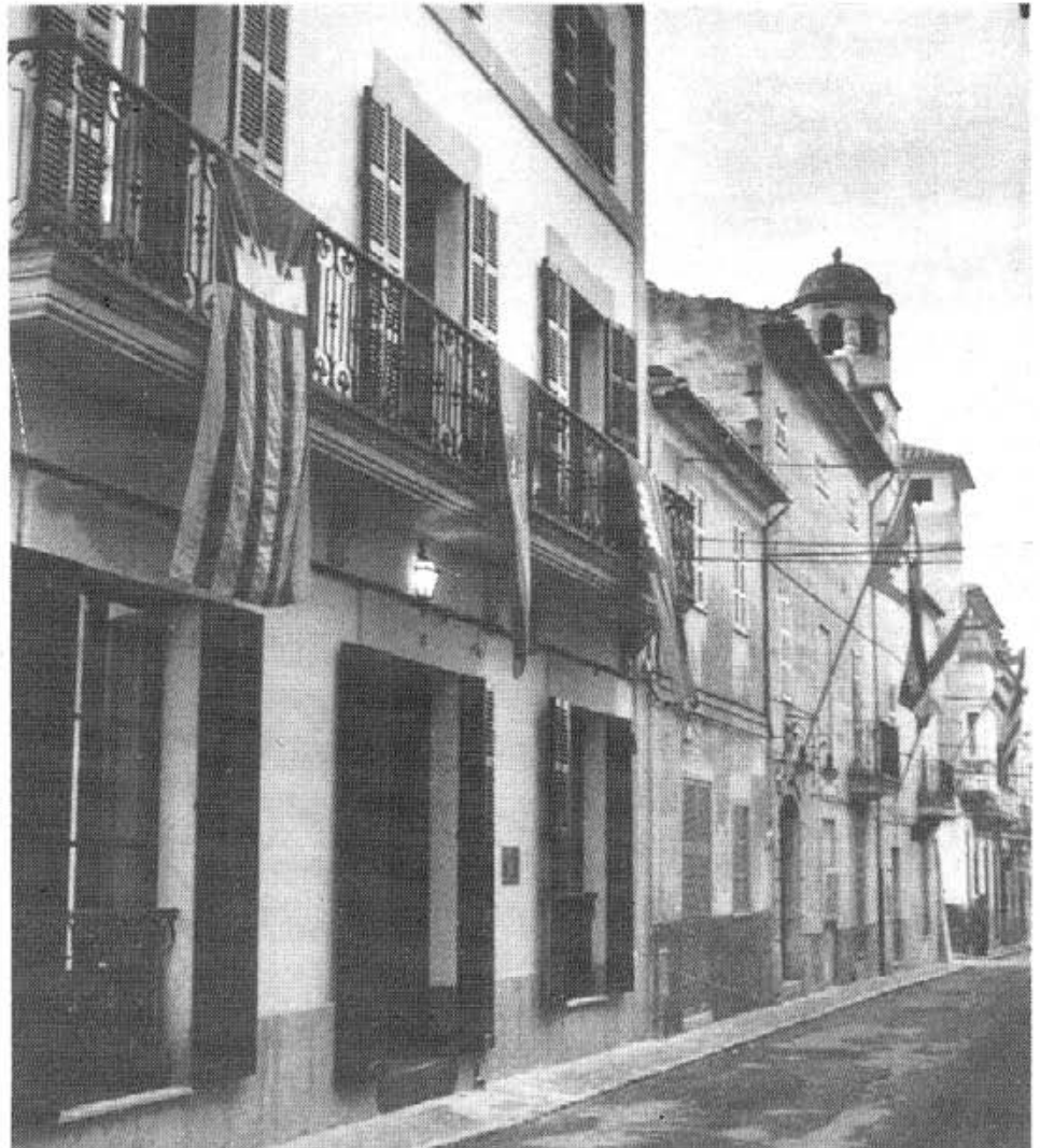
Vista exterior de l'edifici Can Maimó a Petra
