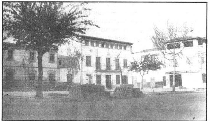
També es fan obres a la plaça de l'Ajuntament
