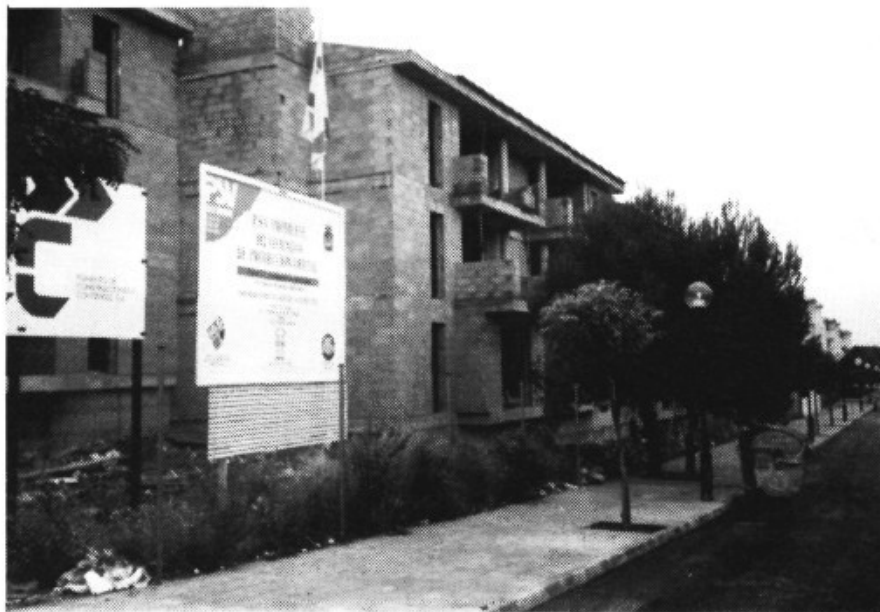
En los terrenos de Son Ferrer, aún escriturados a nombre del Ajuntament de Calvià, se construyen las primeras viviendas sociales.
