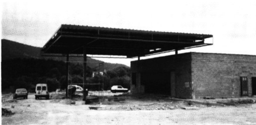
R.C.T. Las obras están muy adelantadas
