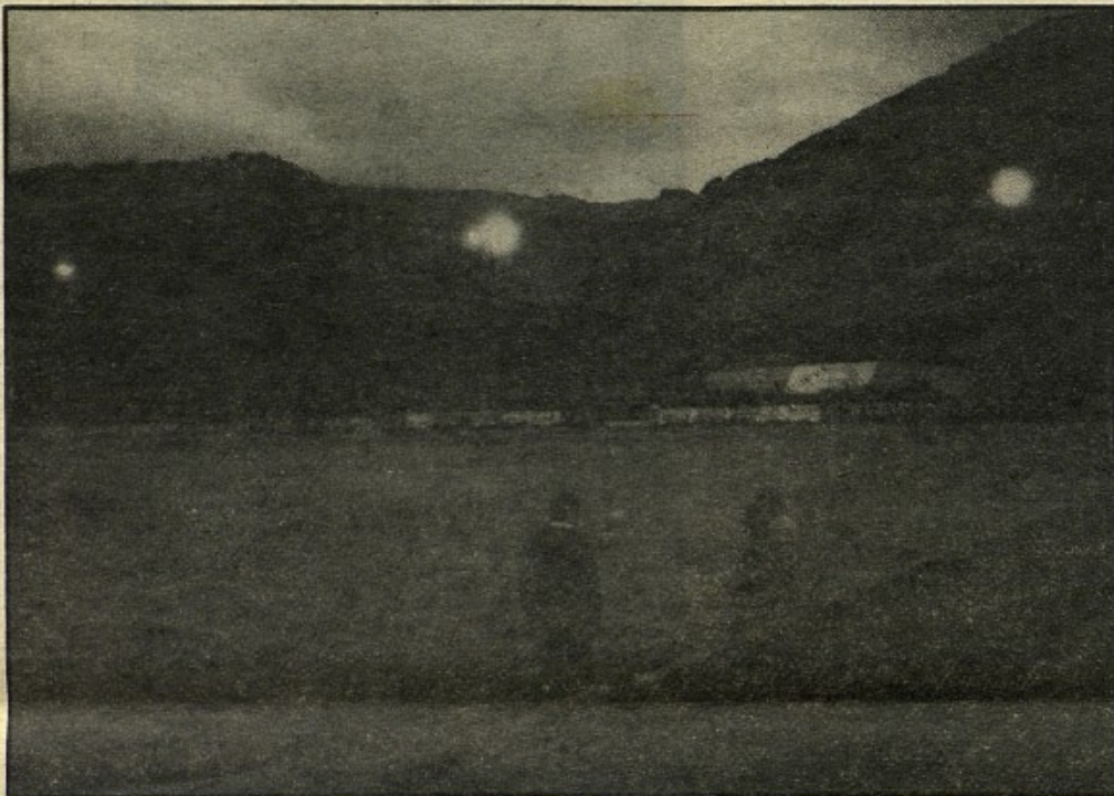
No son "Ovnis", és la nova instal·lació elèctrica de Ca'n Escarritxó, captada pel nostre reporter Pep Bordoy.
