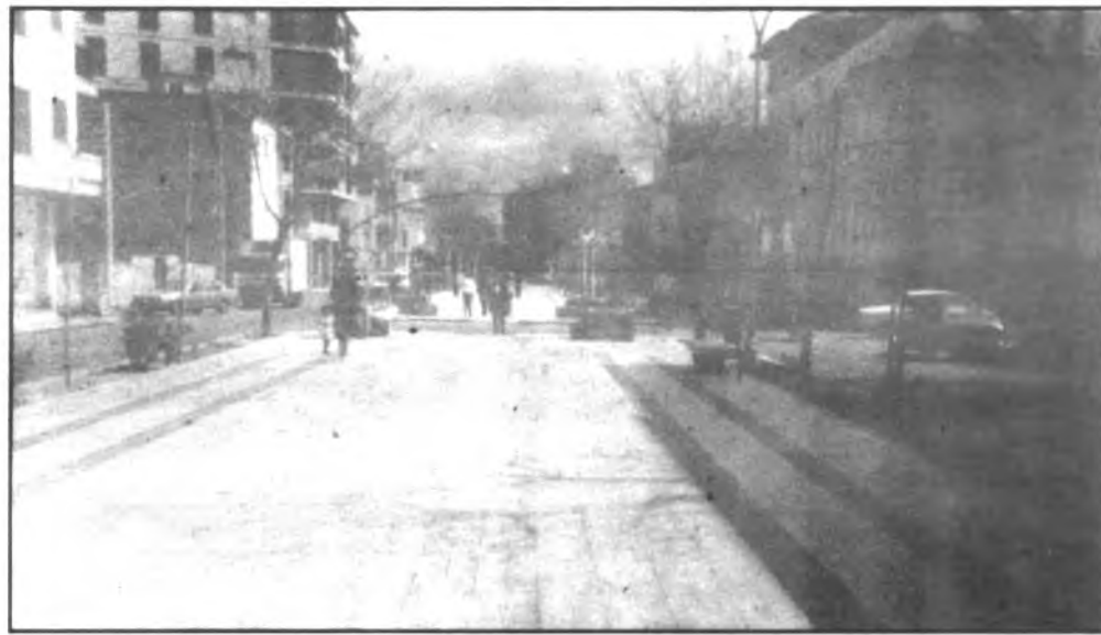
Los vecinos de la Gran Vía de Colón se quejan del estado de abandono de la Avenida.
