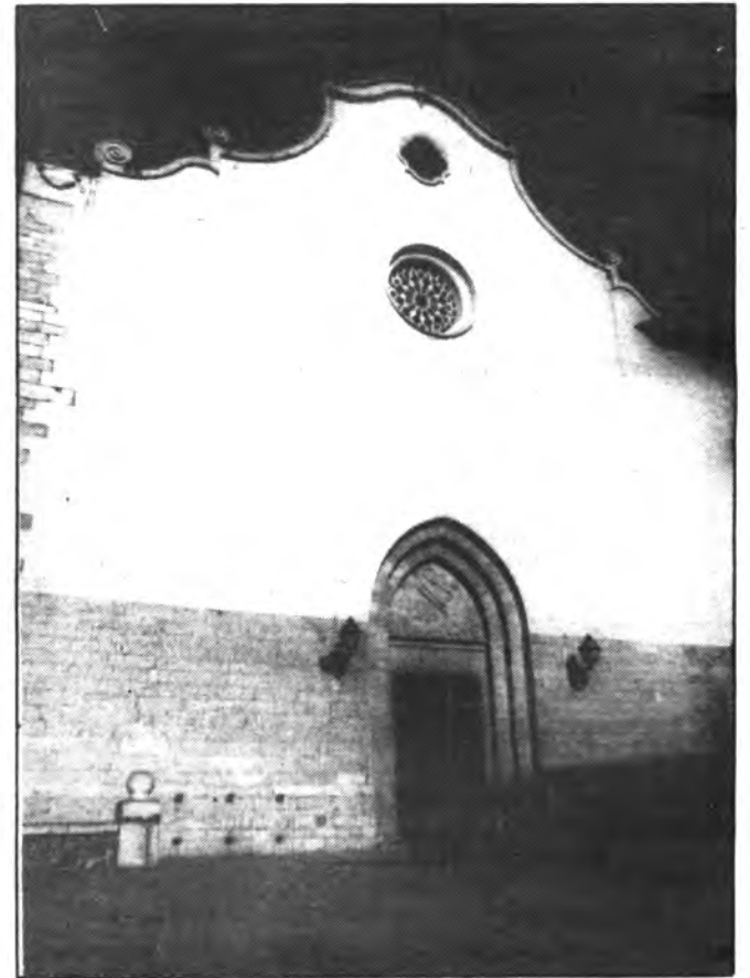
Sant Francesc en obras.
