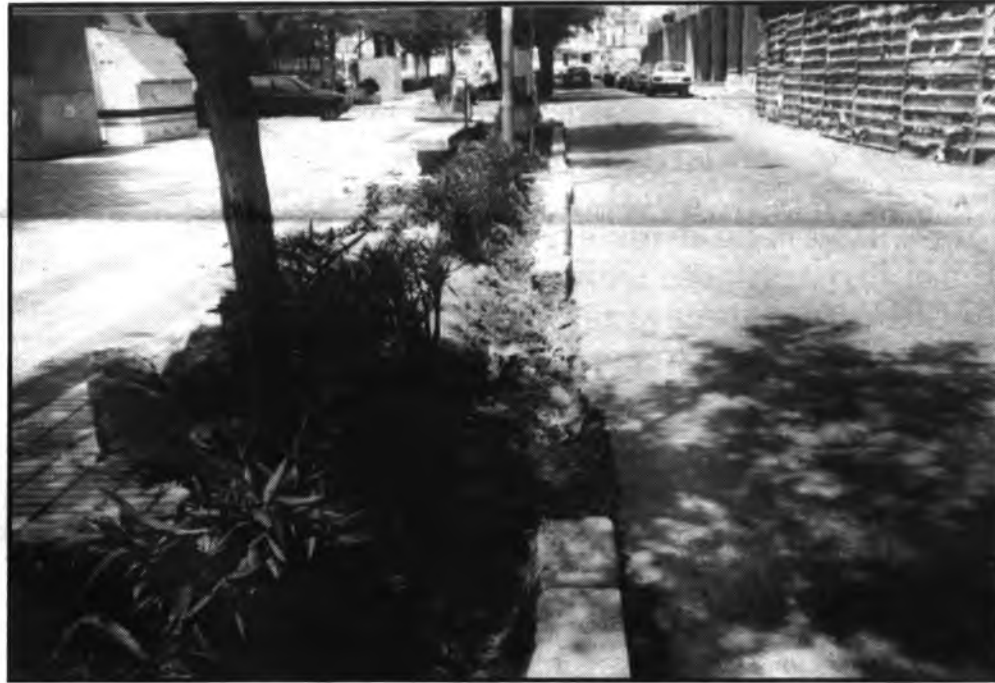
Definitivamente, se arregla el bordillo de la Gran Vía de Colón (Foto: A. QUETGLAS).
