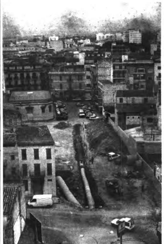
Reforma de la Gran Via de Colón, con la Avenida Bisbe Llompart.
