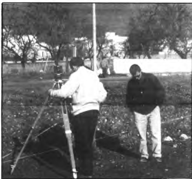
Han comenzado las obras en el Polígono.
