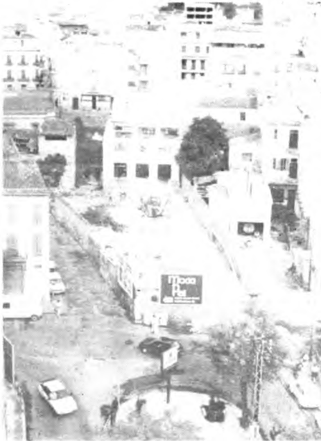
Ca'n Noguera, demolición de unas instalaciones zapateras con 51 años de historia. (Foto: PAYERAS).
