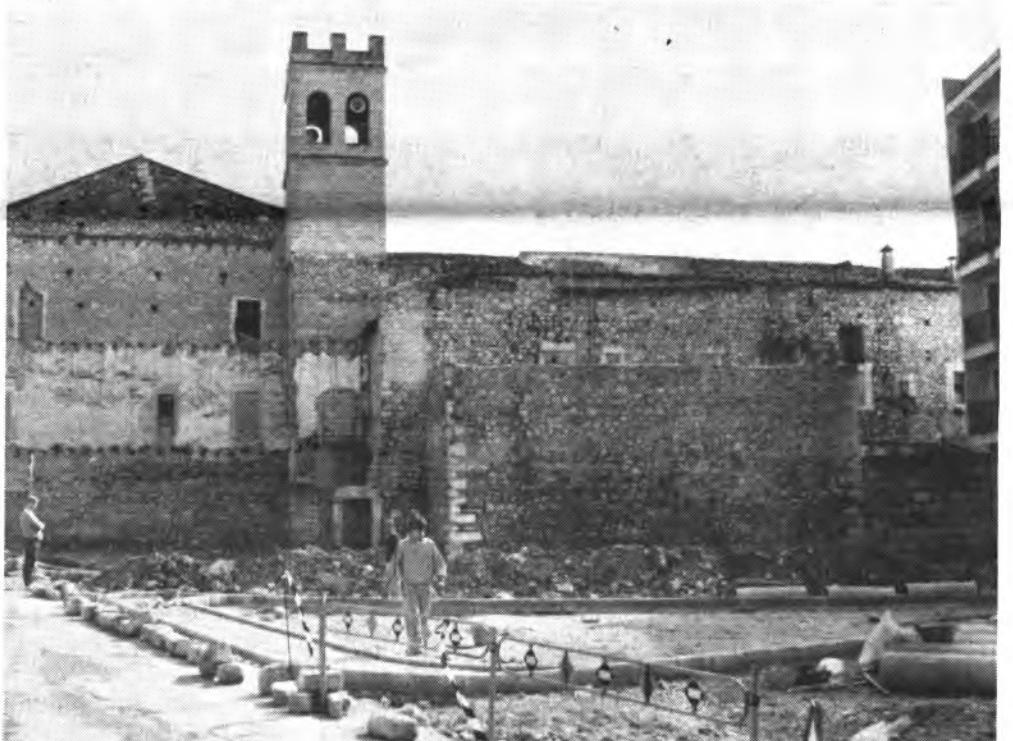
Obres de la reforma del carrer d'almogàvares (Foto: Payeras).
