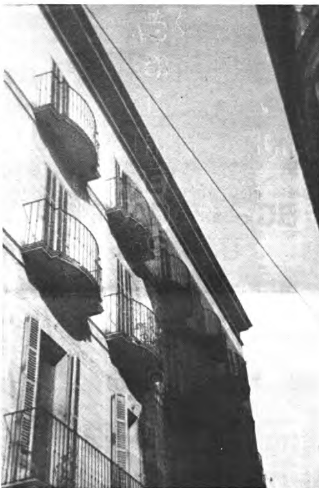
Fachada Fonda Victoria (Foto: ANDRES QUETGLAS)
