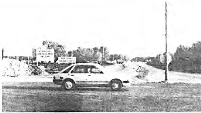
Aspecto de las obras (Foto: J. Riera).
