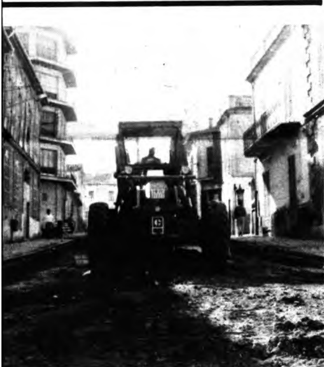
Detalle de las obras de la Avinguda del Bisbe Llompart. (Foto: Payeras).
